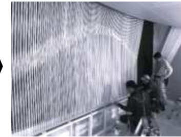
現場取付風景
